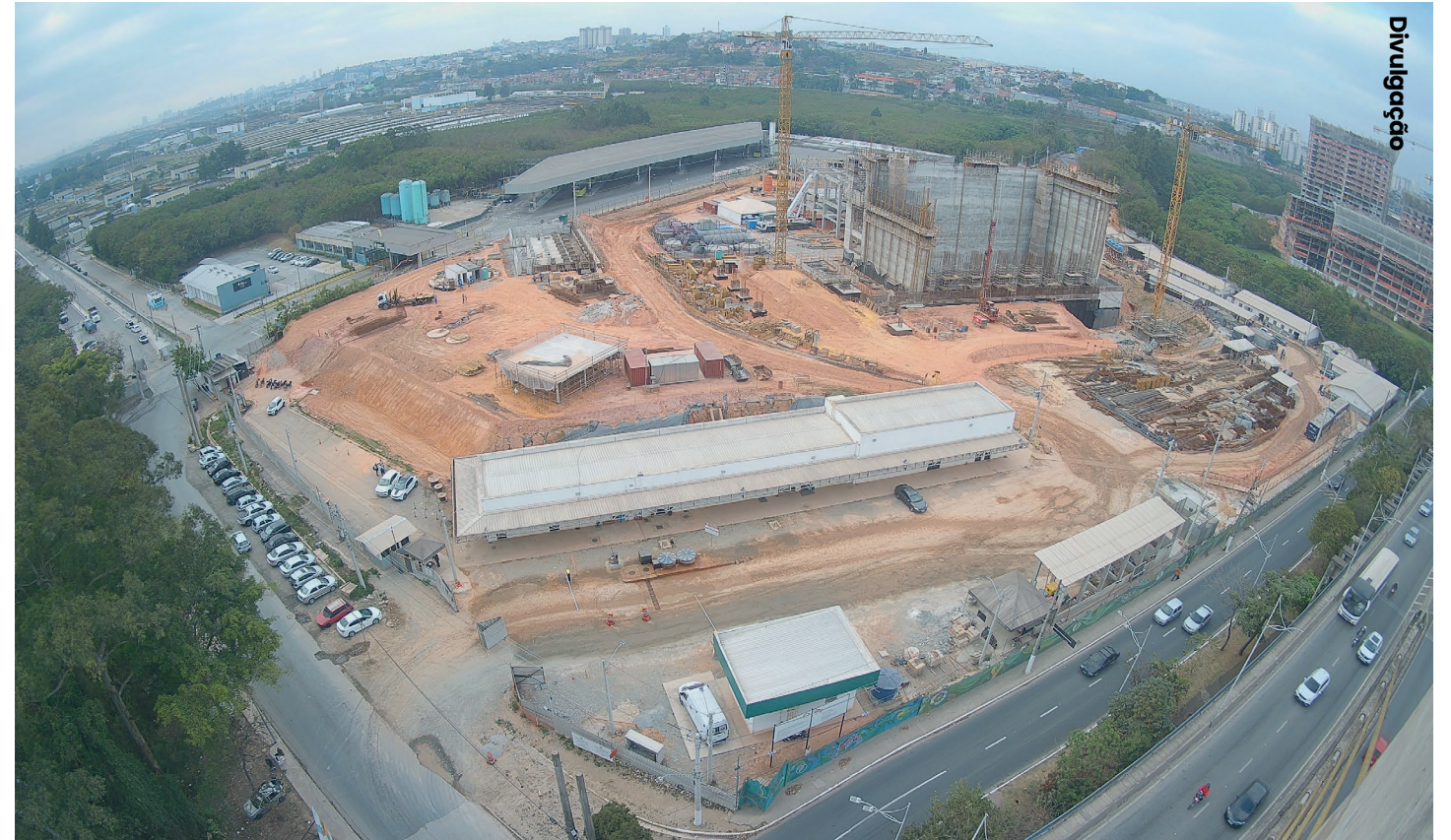
Área onde está sendo construída a URE Barueri , primeira usina Waste-to-Energy da América Latina
